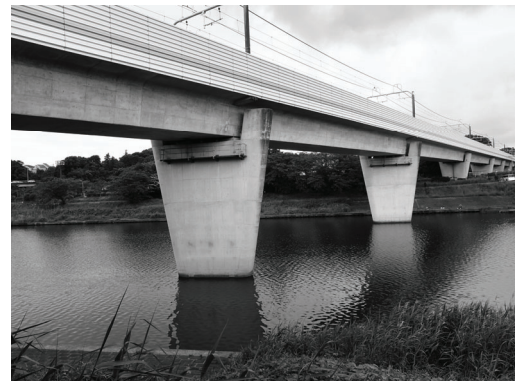
コンクリート橋
